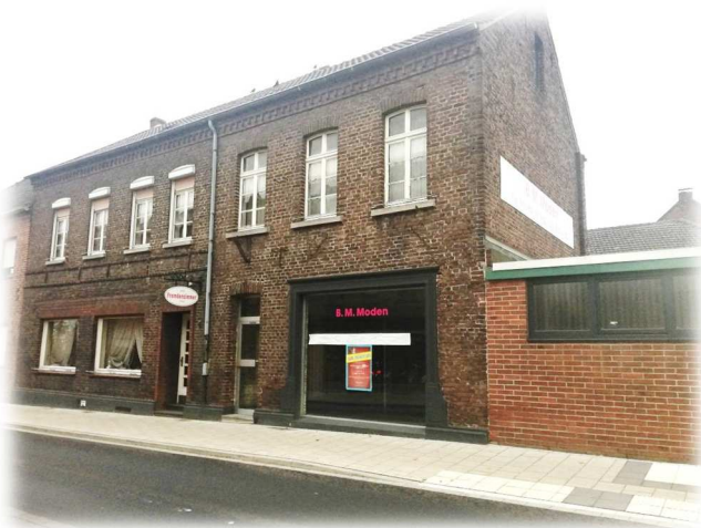
Südwall 5 in Straelen
