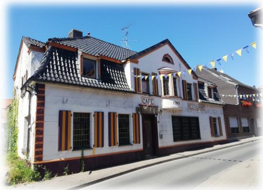
Walbecker Straße 25 in Walbeck
