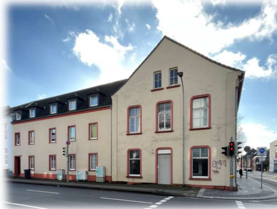
Bahnhofstr. 9 / Südwall 45 in Geldern
