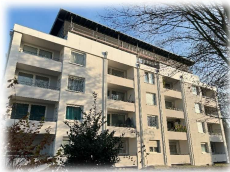
Modernisierung Geldern, Vernumer Str. 54
