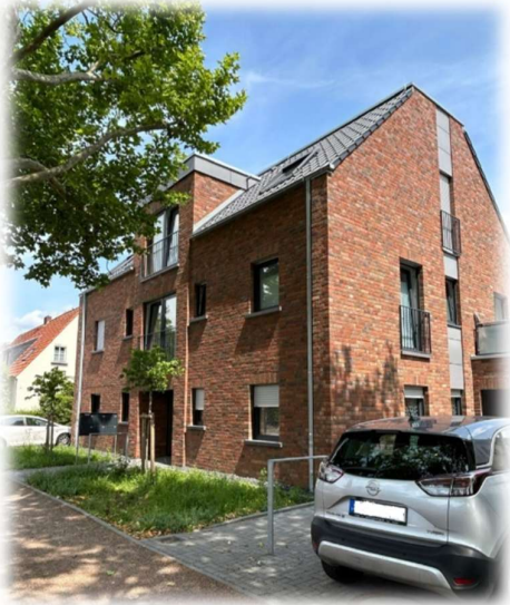
Neubau Geldern, Breslauer Straße 2a
